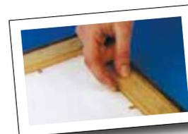
Enfoncement horizontal de lamelles flexibles.
